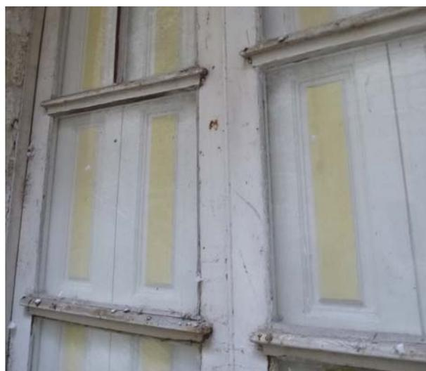
Relevé et détail d'une fenêtre d'imposte ayant conservé le panneau vitré assemblé au plomb d'origine. Remplacement des panneaux par des carreaux. Rue St-Vincent, sur cour.
