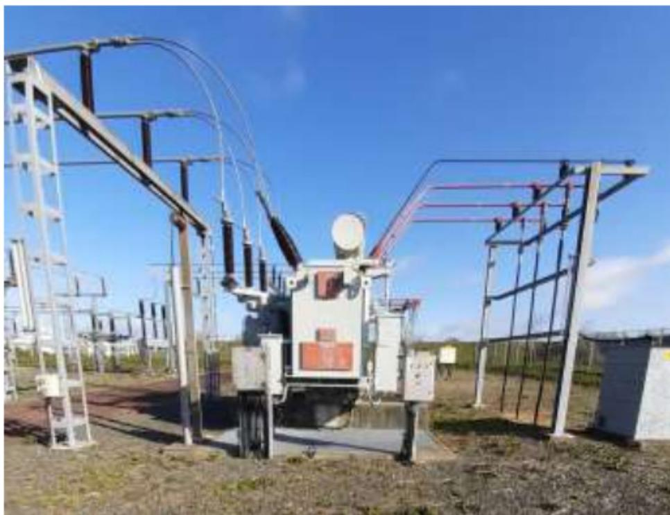
*Photo d'un exemple de mutation de transformateur 90/20 kV de 20 MVA en 36 MVA – poste source ISSE*
