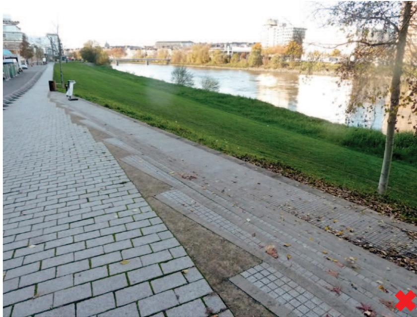
Un raccord par un joint épais, plus adaptable, permet de raccorder des surfaces courbes et irrégulières. En revanche, l'effet produit ici est malheureux car il donne une impression de «rattrapage» entre deux surfaces, d'oubli d'un détail.
