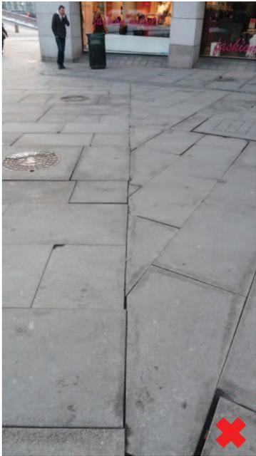
On comprend bien ici que l'absence d'élément de raccord ne permet pas aux modules sciés de s'appuyer sur une ligne, ce qui rend la mise en oeuvre très difficile.
