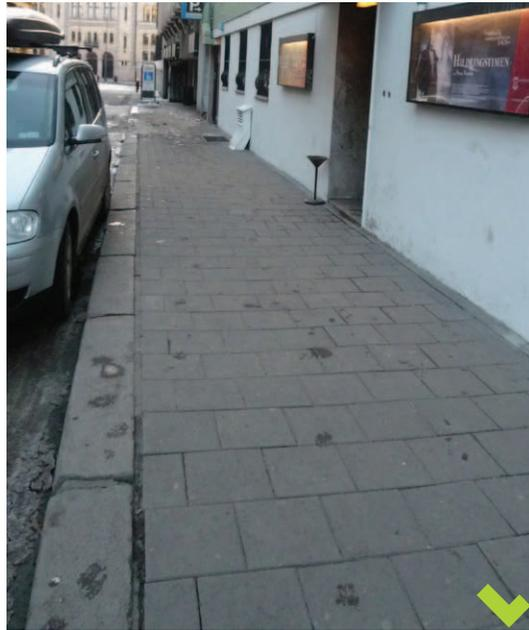
Effets de différentes échelles de modules: les petits modules agrandissent visuellement l'espace, et sont utiles dans des situations resserrées.
