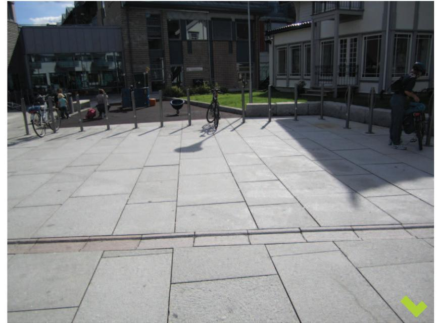
Un raccord avec des éléments modulaires (qui en plus ici servent de caniveau) limite les effets de crans et de joints irréguliers et donne un aspect mieux fini que le raccord avec un joint épais.
