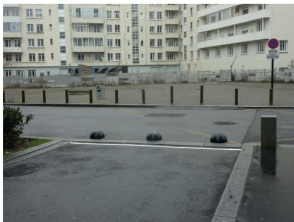
1/2 sphères pouvant bloquer le passage des engins de secours si trop hautes ( $\geq 12$ cm).
