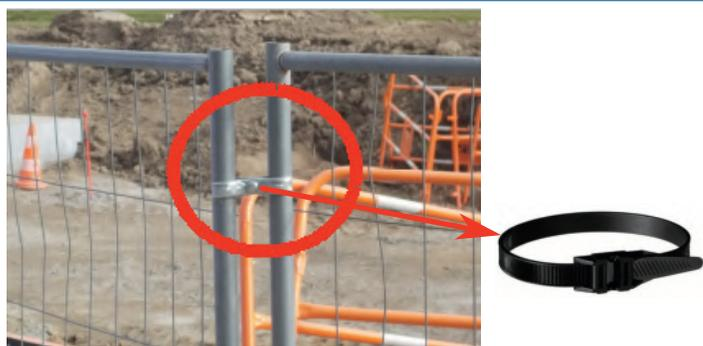
Système de fixation des clôtures
