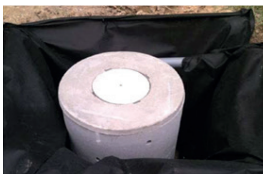
Puits d'infiltration
