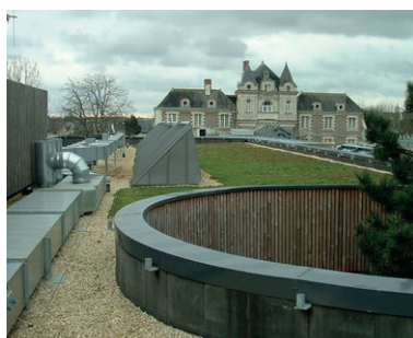
Toiture de la Médiathèque Saint-Luce-sur-Loire
