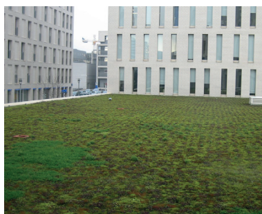
Toiture Magellan à Nantes
