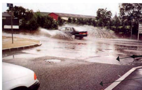
Chaussée à structure réservoir
