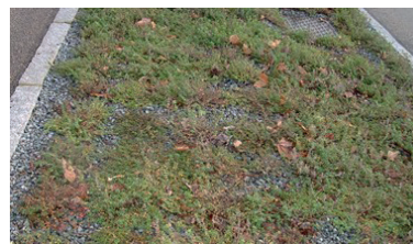
Revêtement en gravier entre voies de busway - Nantes
