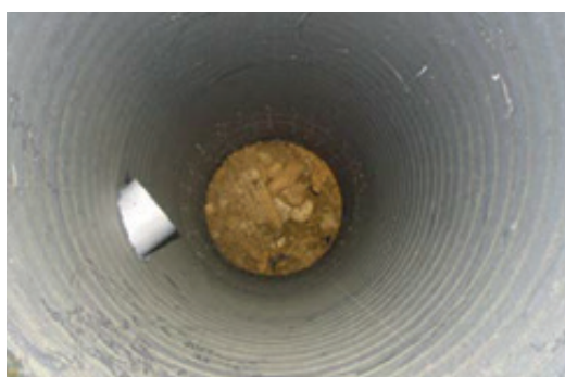
Puits d'infiltration
