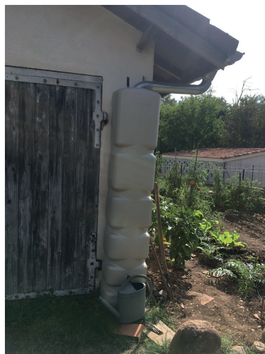
Installation de récupération de l'eau de pluie pour l'arrosage du jardin
