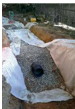
Tranchée d'infiltration sous chemin
