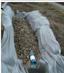
Mise en œuvre d'une chaussée à structure réservoir
