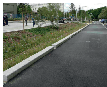
La Courneuve : noue végétalisée avec ruissellement direct
