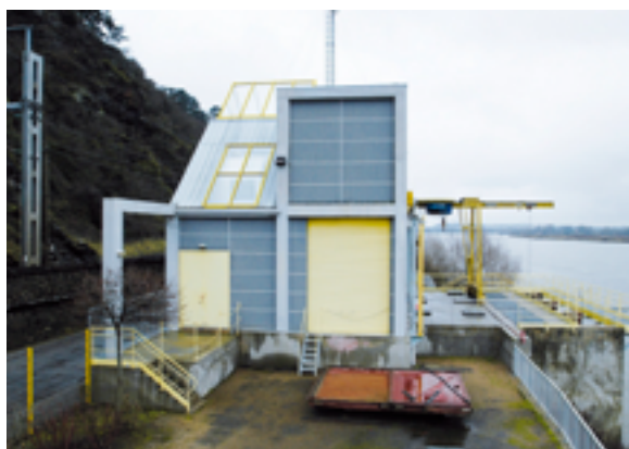
Station de pompage de Mauves sur Loire
