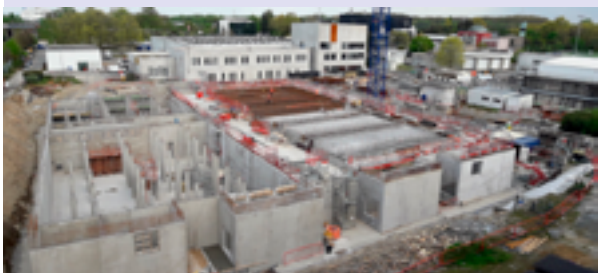
Construction des filtres à sable
