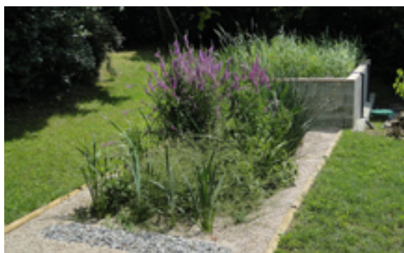
Filtres plantés, un assainissement non collectif naturel
