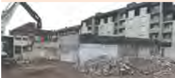
Démolition des anciens ateliers Normands
