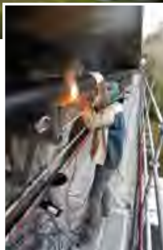
Renouvellement canalisation en encorbellement - pont de la Noué Verrière (La Chapelle-sur-Erdre)
